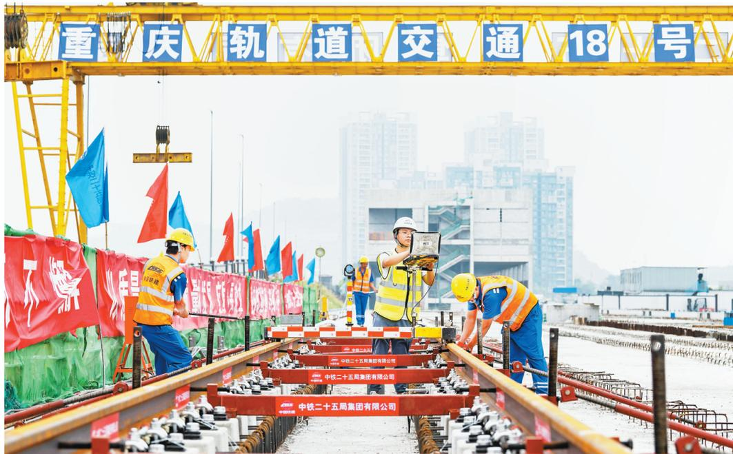
重庆轨道交通18号线伏牛溪铺轨基地,中国铁建技术人员正在进行首幅轨排铺设。(资料图片)
