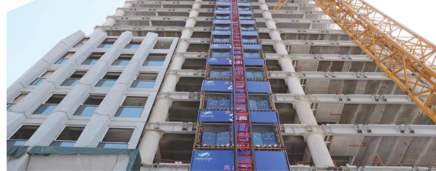
中科大厦项目
