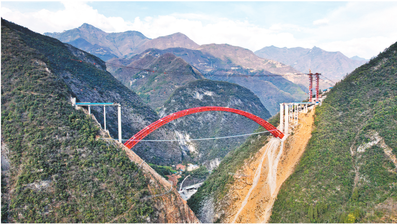
修建中的巫镇高速东溪河特大桥。
