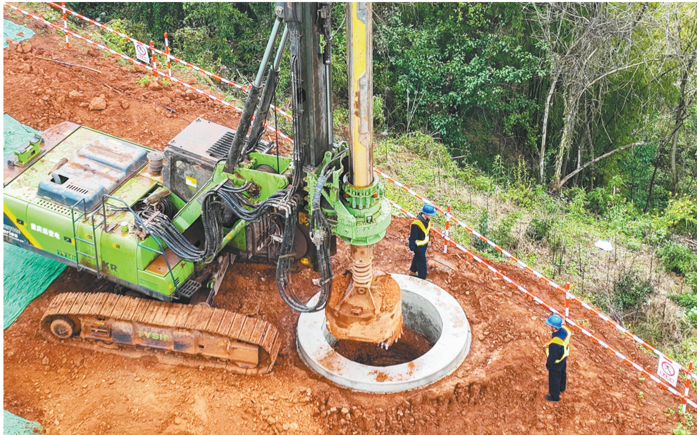
近日,在川渝1000千伏特高压交流工程(重庆段)施工现场,旋挖机正在进行基坑开挖作业。(资料图片)
