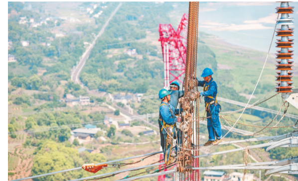
在江津区白浙线长江大跨越施工现场,施工人员正在进行导线附件安装。白浙线是国家西电东送的重大电网工程。(资料图片) (国网重庆市电力公司供图)
