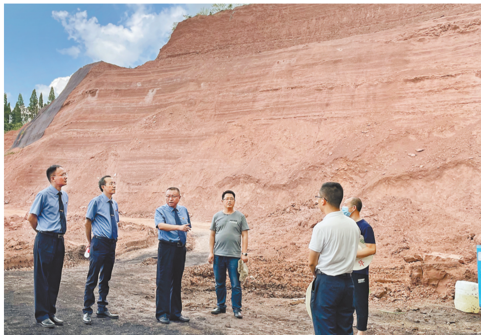
重庆市检察院第一分院、沙坪坝区检察院联合四川省遂宁市检察院、遂宁市船山区检察院公益诉讼检察官到固体废物堆放现场开展实地勘察。重庆市检察院第一分院供图
