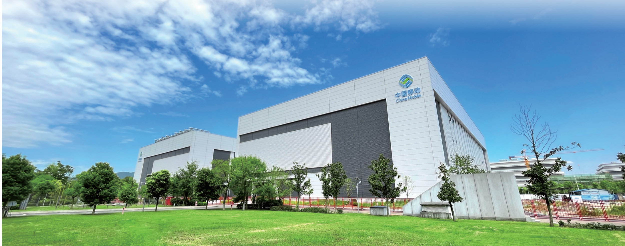
位于重庆两江新区水土新城的中国移动(重庆)数据中心
