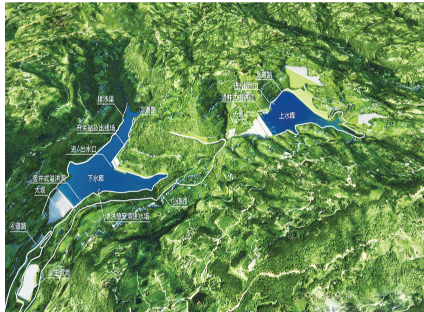
云阳建全抽水蓄能电站鸟瞰图
