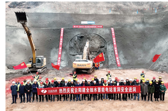
云阳建全抽水蓄能电站首洞安全进洞
