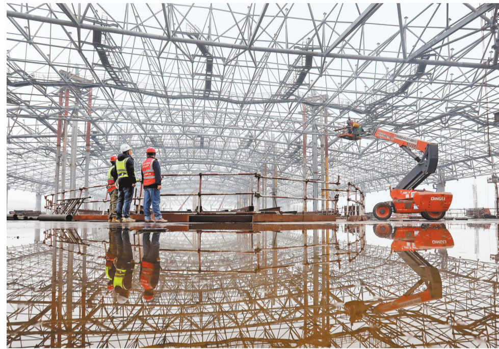
重庆机场T3B航站楼,工人正在进行航站楼钢结构施工。(摄于二月二十日) 记者 罗斌 摄/视觉重庆
