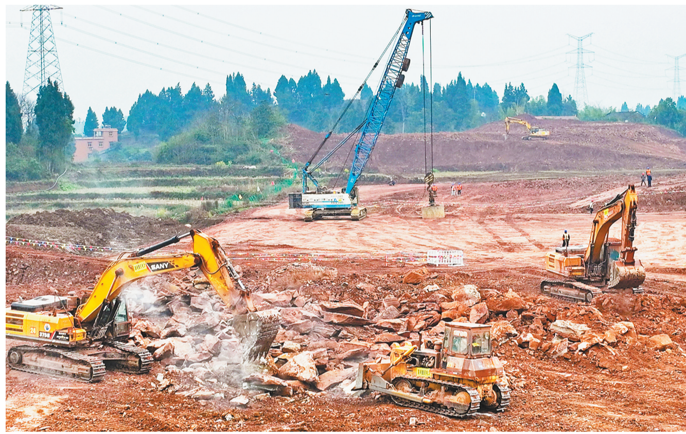
3月1日,铜梁区少云镇高碑村,铜梁1000千伏变电站正在进行强夯施工作业。
