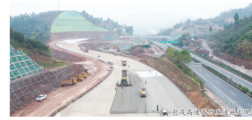
包茂高速高竹互通施工现场
