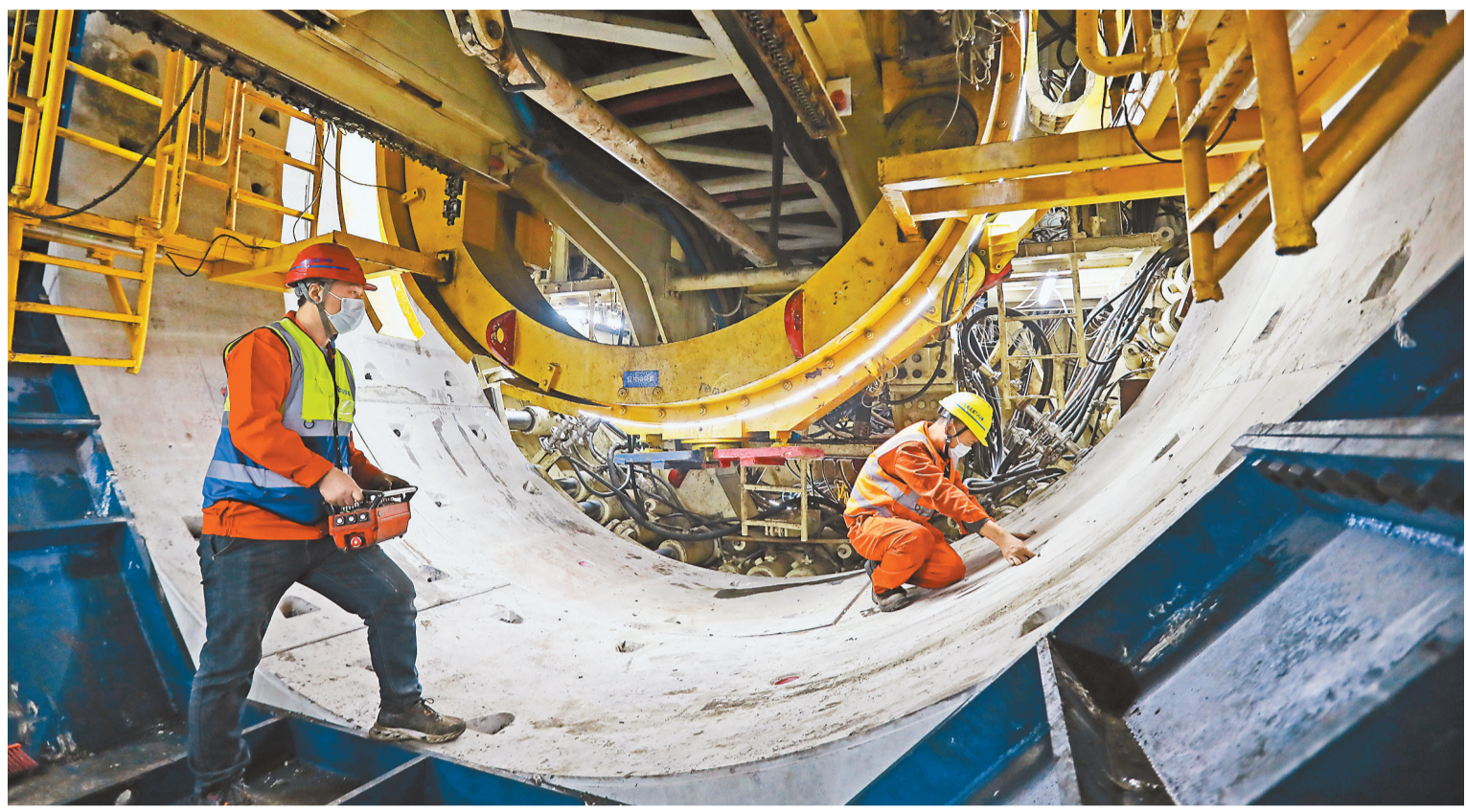
轨道交通3号线北延工程全线首台“TBM”渝越一号，在渝中区大坪西站至终点区间段顺利掘进(本报资料图片) 记者 罗斌 摄/视觉重庆
