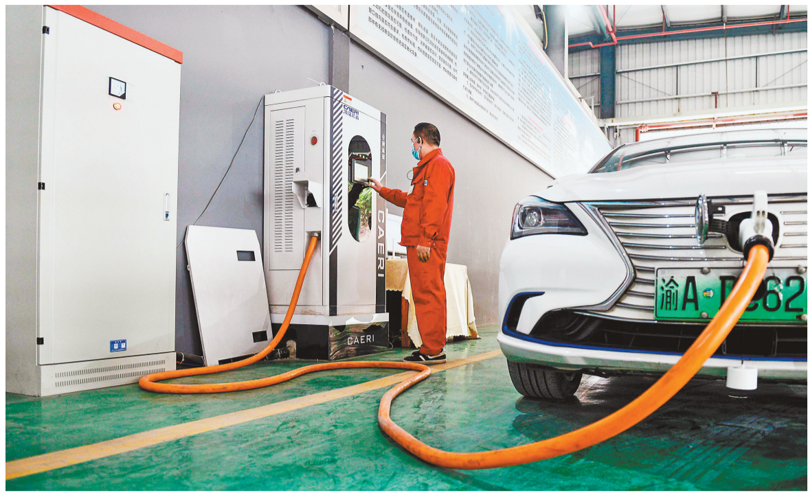
二〇二二年十二月八日，渝北区金锦路，工人在新能源汽车检测站对我正式上线投入使用。
