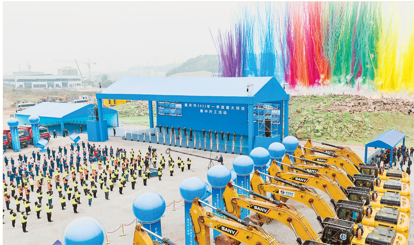
二月十八日,九龙坡区陶家镇红马天泰新能源正极材料研发生产基地,重庆市2023年一季度重大项目集中开工活动现场。记者 谢智强 摄/视觉重庆
