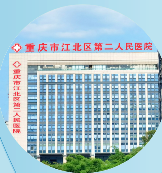
江北区第二人民医院扩建工程
