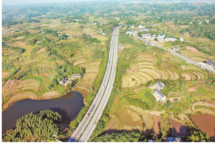
西南第一路——成渝高速公路。(重庆高速集团供图)
