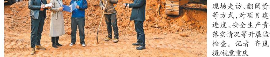
2月6日，成渝中线高铁大足黄莲堡隧道施工现场，重庆大足区、四川安岳县纪委监委的干部在了解施工进度情况。
