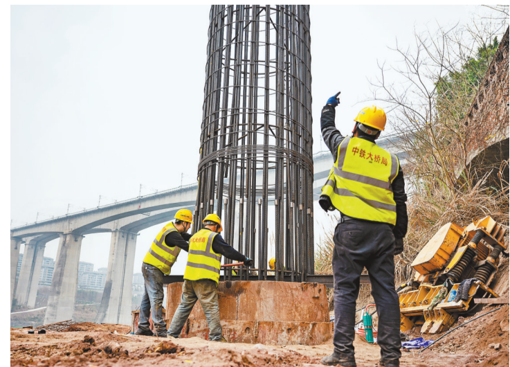
2月7日,沙坪坝井口二塘码头,成渝中线高铁井口嘉陵江特大桥施工现场,工人正在进行桩基钢筋笼下放。
