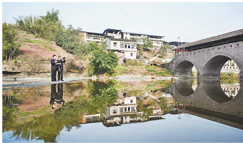
合川区检察院公益诉讼干警对五星桥修缮保护情况进行整体评估。(合川区检察院供图)
