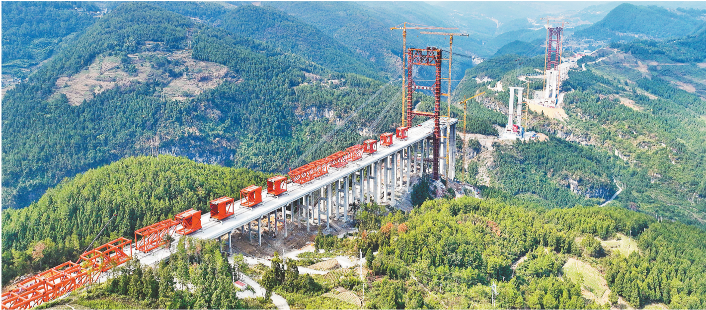
渝湘高速公路复线双堡特大桥首节主拱肋完成吊装(摄于2022年9月6日)。渝湘高速复线建成后将进一步拉近南川等地城镇群与中心城区的距离。按规划，我市将不断完善交通网络，着力形成1小时交通圈、通勤圈，推动郊区新城建设。 记者 罗斌 摄/视觉重庆
