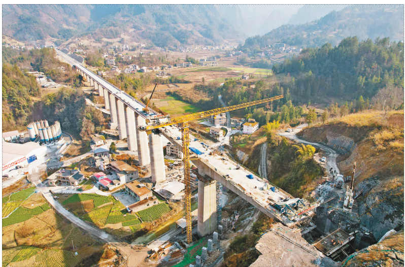
渝湘高铁灯光村特大桥春节期间加紧施工。(中铁十七局供图)
