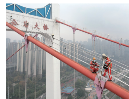
市照明中心工作人员在寒风中维修大桥灯饰
