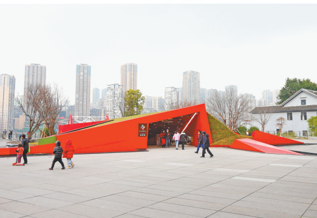
1月18日,10号线二期曾家岩站与周公馆相邻,是唯一一座建在路面上的轨道站。 特约摄影 钟志兵/视觉重庆
