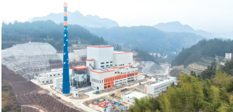
黔江垃圾焚烧发电厂
