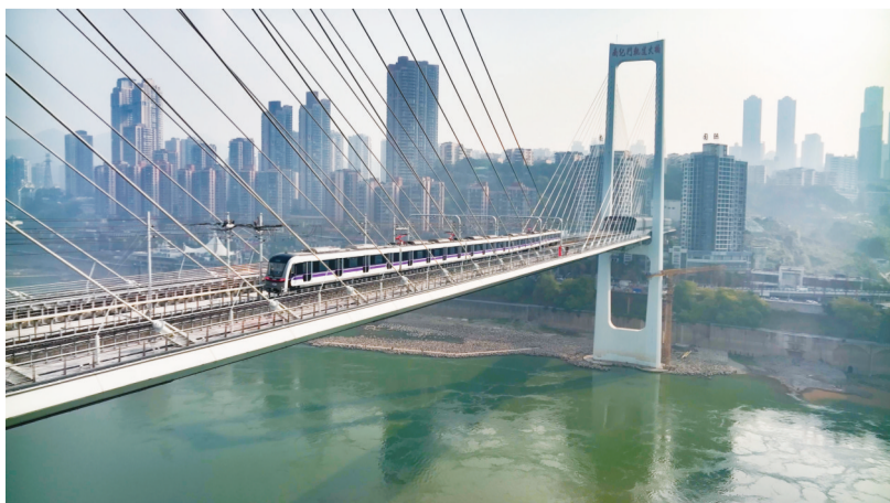
10号线二期南纪门轨道专用桥
