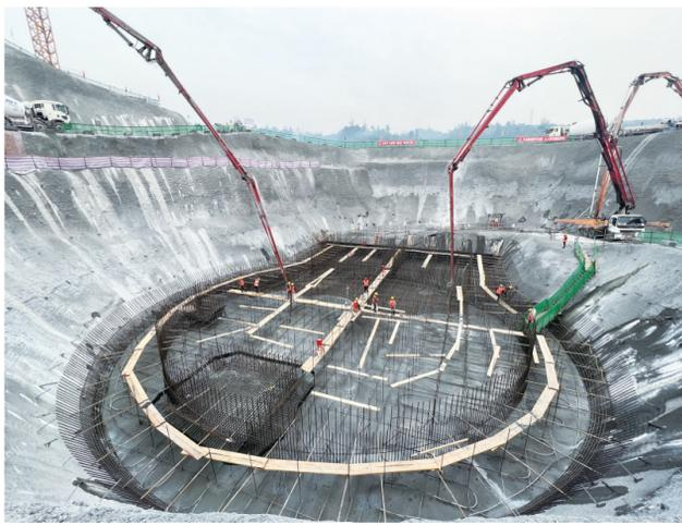
渝西水资源配置工程—草街泵站底板混凝土浇筑
