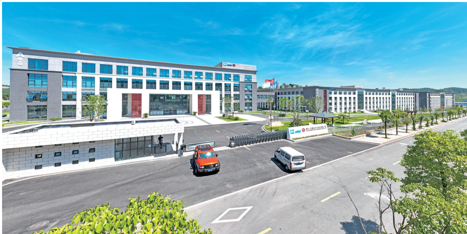
位于重庆市中医药产业科技园的上药慧远生产厂房 摄/汪新
