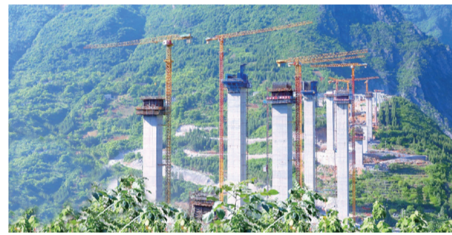
建设中的巫镇高速
