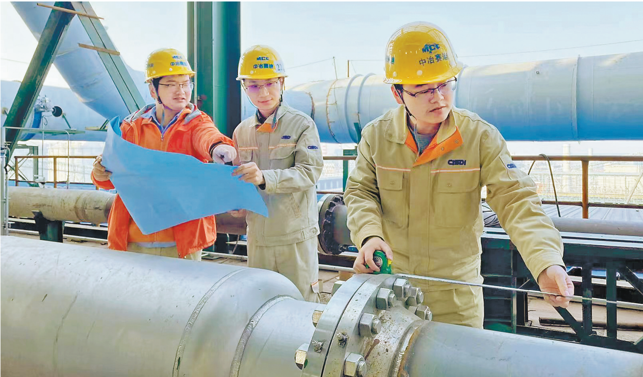
中天炼钢项目青年突击队队员在施工现场
