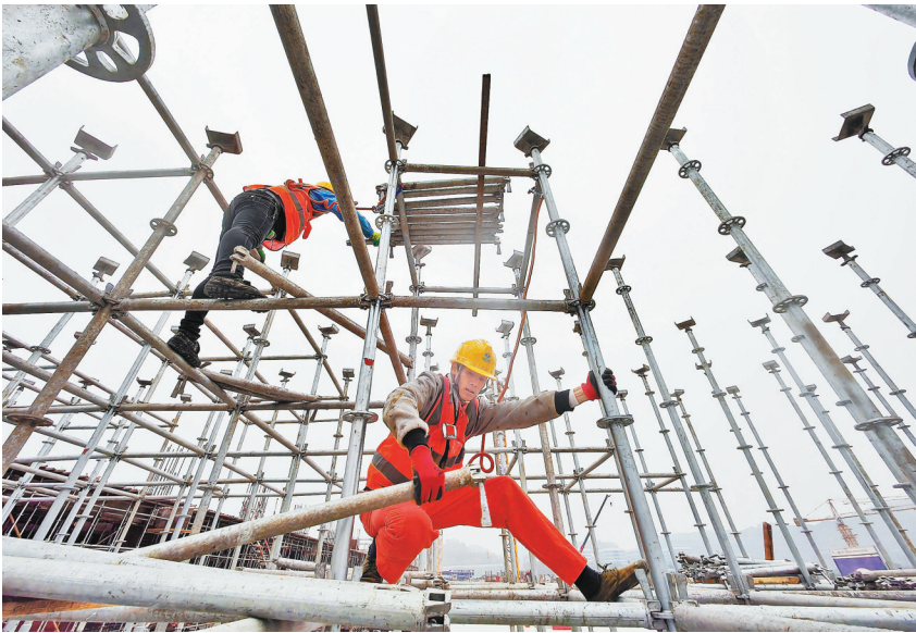
▲12月16日，西部(重庆)科学城科学会堂项目，工人正在搭支架。
