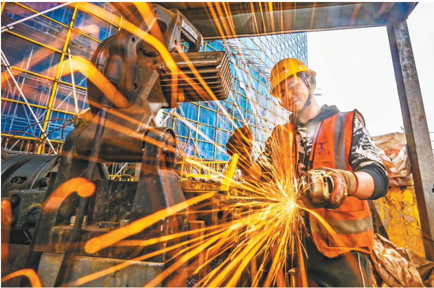
▲12月9日，西部(重庆)科学城科学谷二期施工现场，工人正在切割钢筋。
