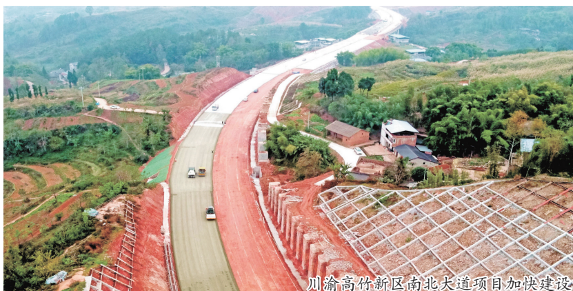
川渝高竹新区南北大道项目加快建设
