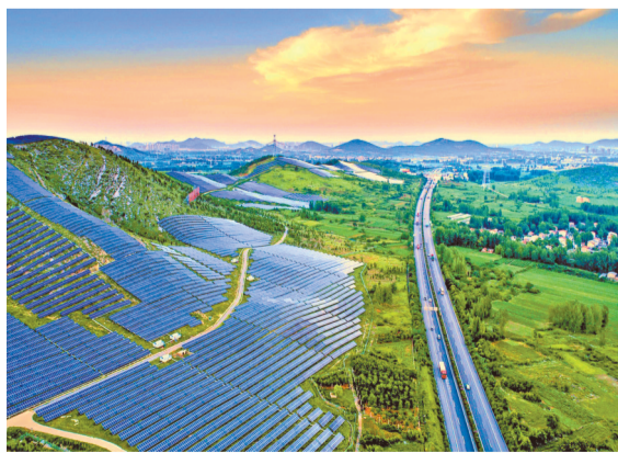
石渝高速涪陵段，路旁的山坡上建起了光伏发电设备。
