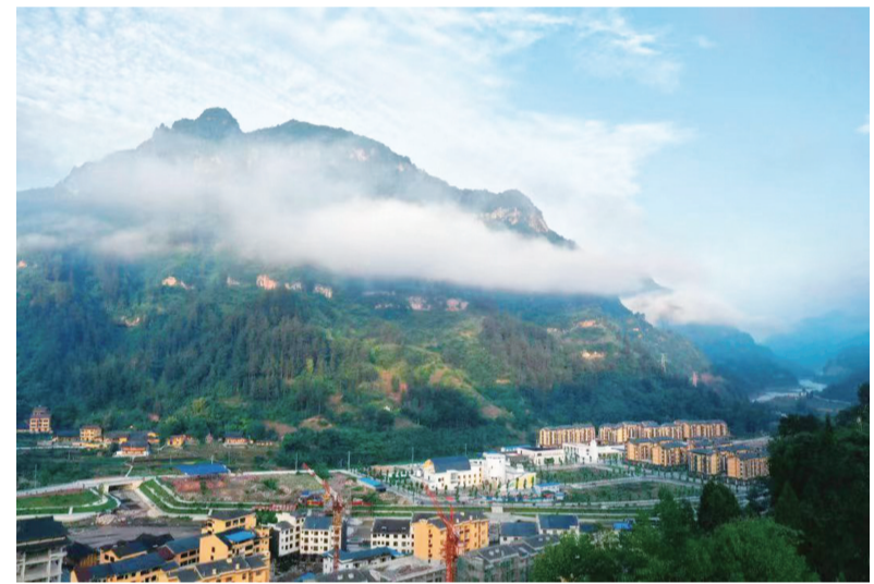
金科援建石柱县中益乡镇环境综合治理
