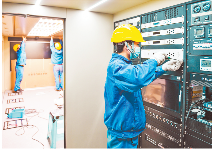
12月3日,迪马工业的工人们正在为即将交付的卡塔尔世界杯通信指挥车安装设备。
