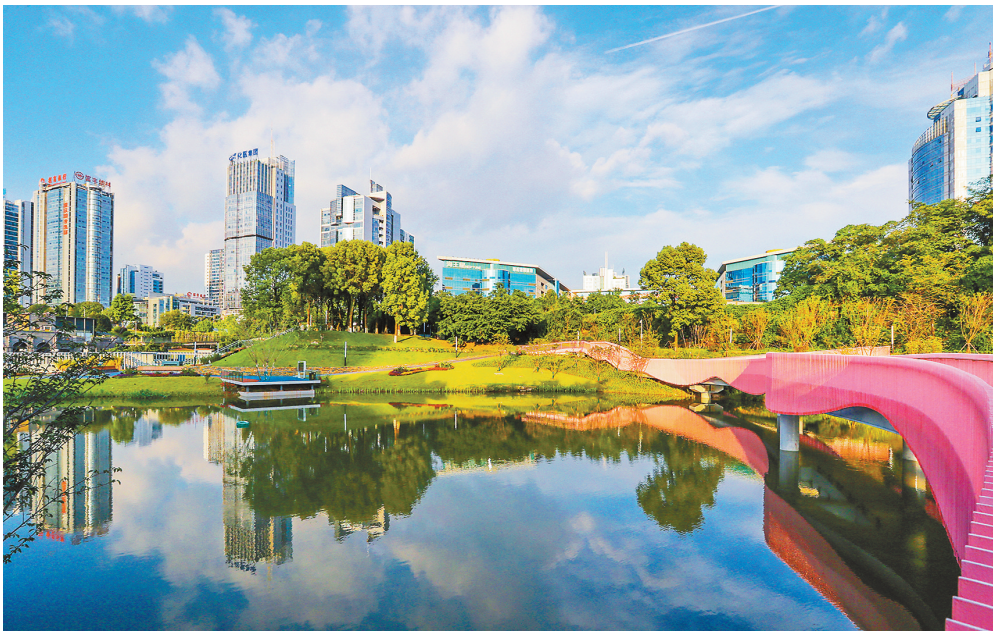
图为盘溪河(百林水库)“清水绿岸”治理提升实景图。
