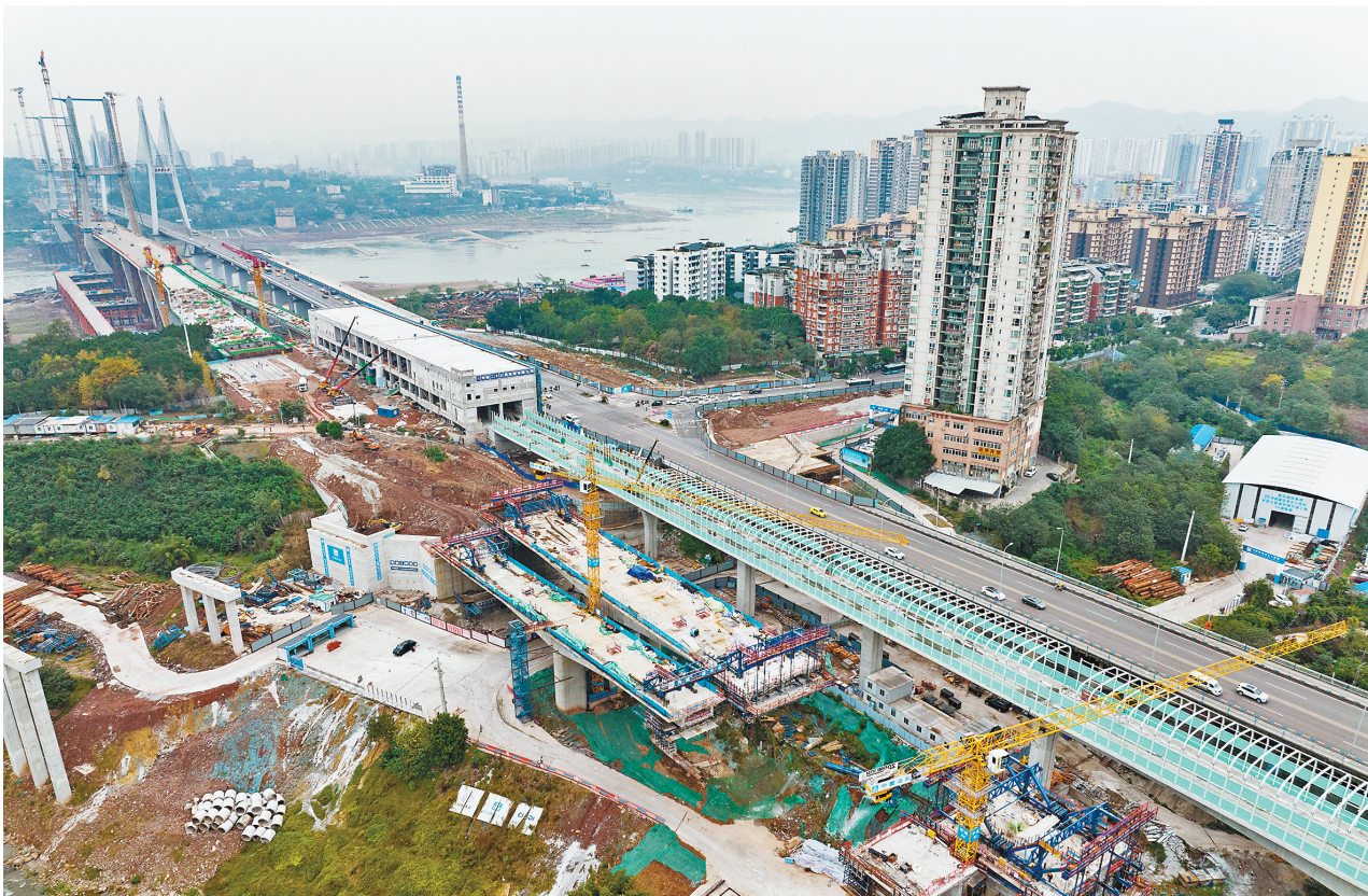
12月6日,巴南区李家沱复线桥南引道工程现场。据悉,李家沱复线桥南引道工程已于近日全面恢复施工。目前,工程开工作业面已达70%。
