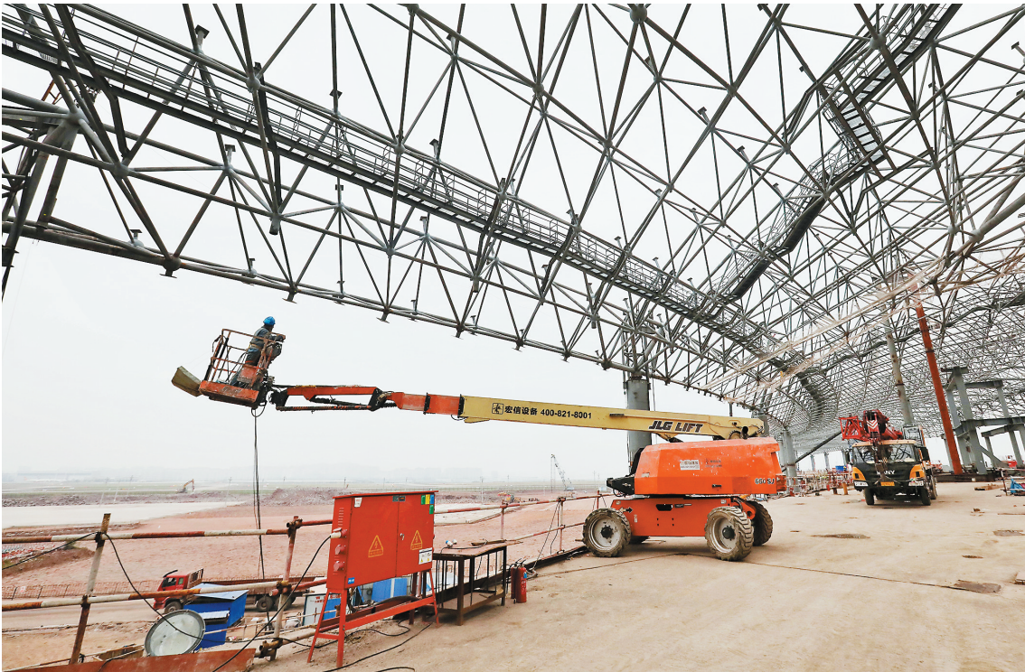
十一月十八日,江北国际机场T3B航站楼,中建八局一千多名技术工人正在紧张施工。目前,T3B航站楼指廊钢结构施工基本完成,正全力攻坚航站楼大厅建设。记者 罗斌 摄影 视觉重庆
