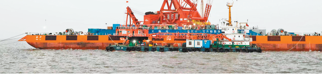
11月20日拍摄的长江口二号古船整体打捞出水施工现场。
