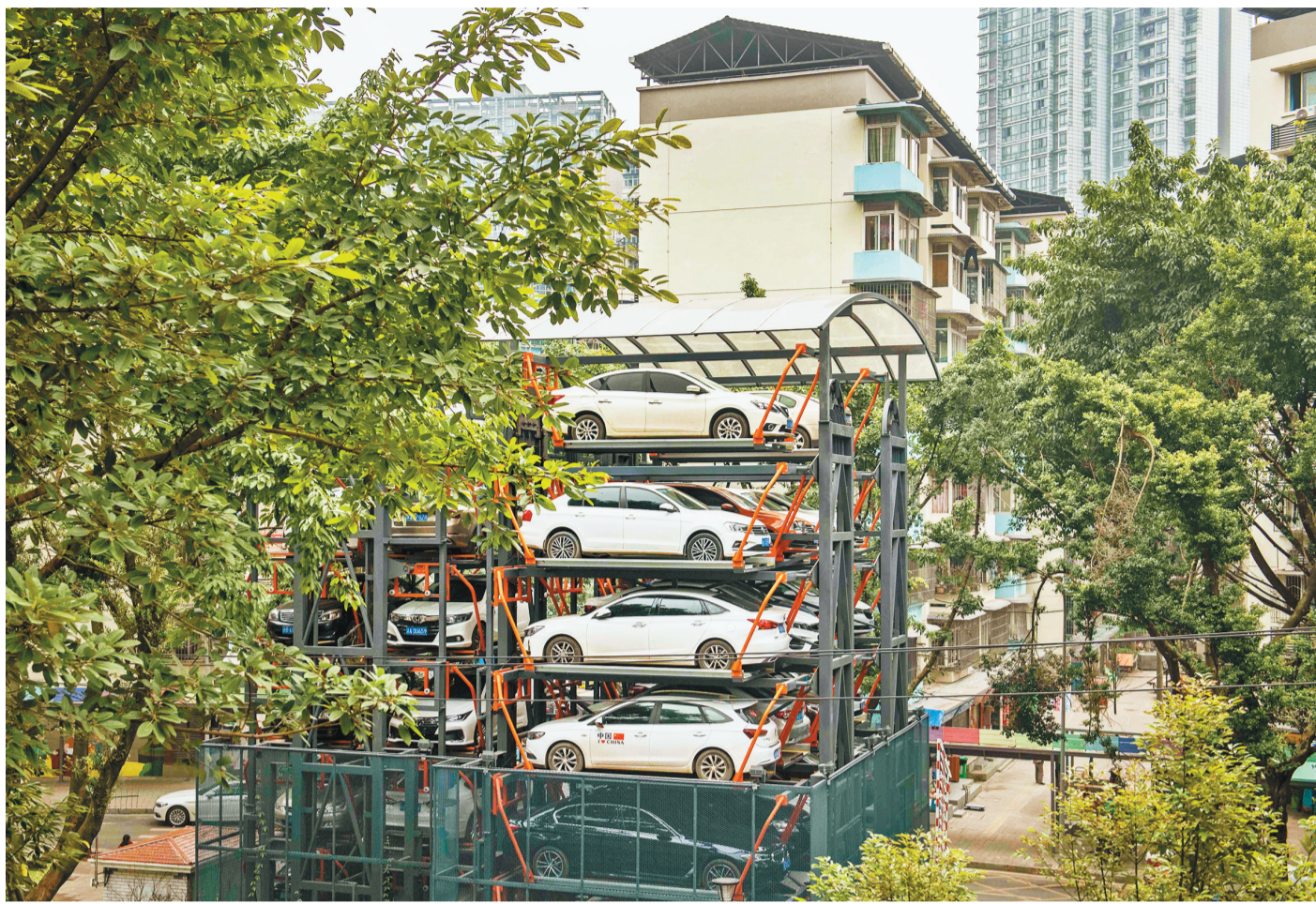
九龙坡区白夹巷老旧小区机械停车场，让周边居民停车不再愁。(资料图片) 记者 张锦辉 摄/视觉重庆
