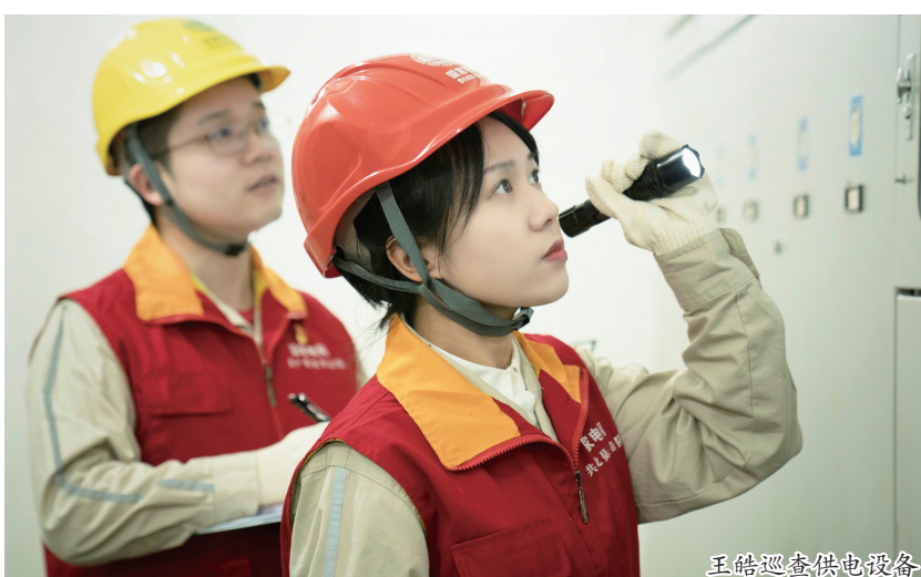
王皓巡查供电设备
