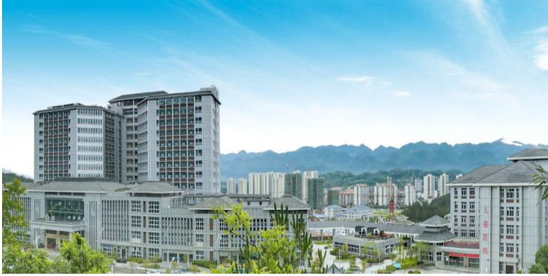
建设中的黔江中心医院正阳新院区
