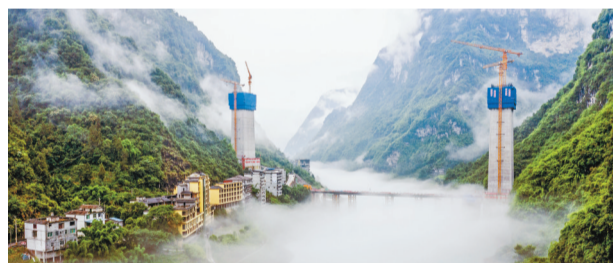
中铁建重庆投资集团承建的渝湘复线高速彭水磨盘寨乌江特大桥 摄/周玖林
