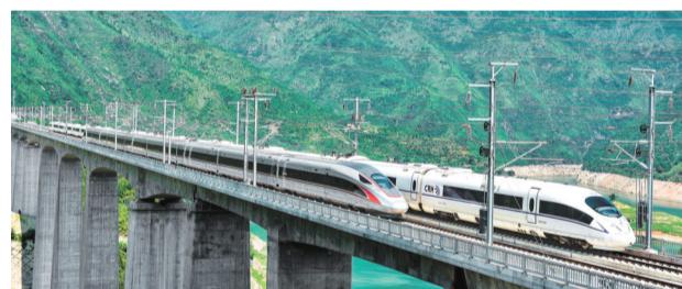
动车疾驰在郑渝高铁重庆巫山境内的大宁河双线特大桥上 摄/王忠虎
