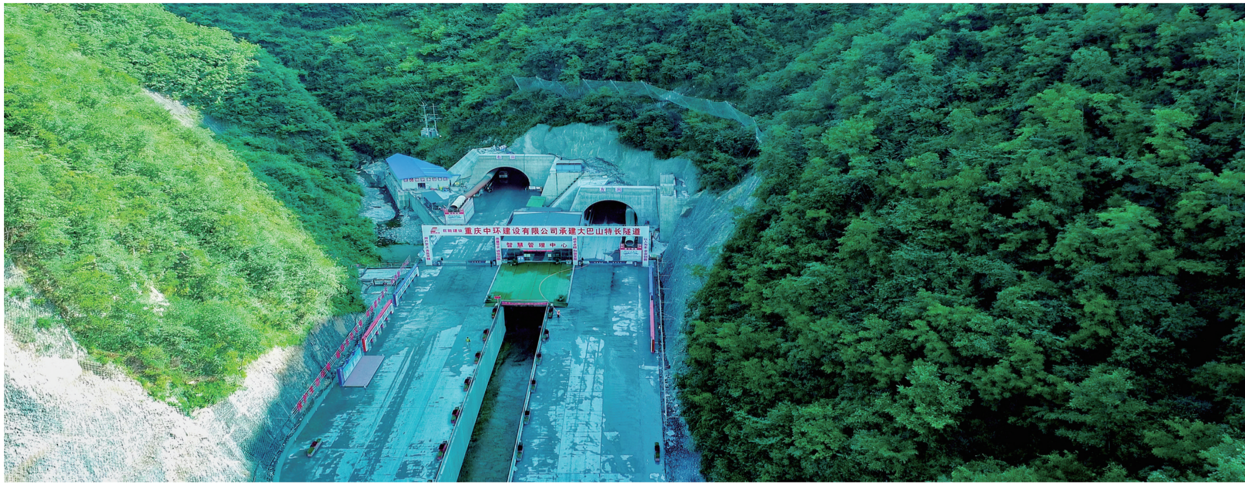
巨能集团中环公司承建的城开高速大巴山隧道正在紧锣密鼓地掘进中
