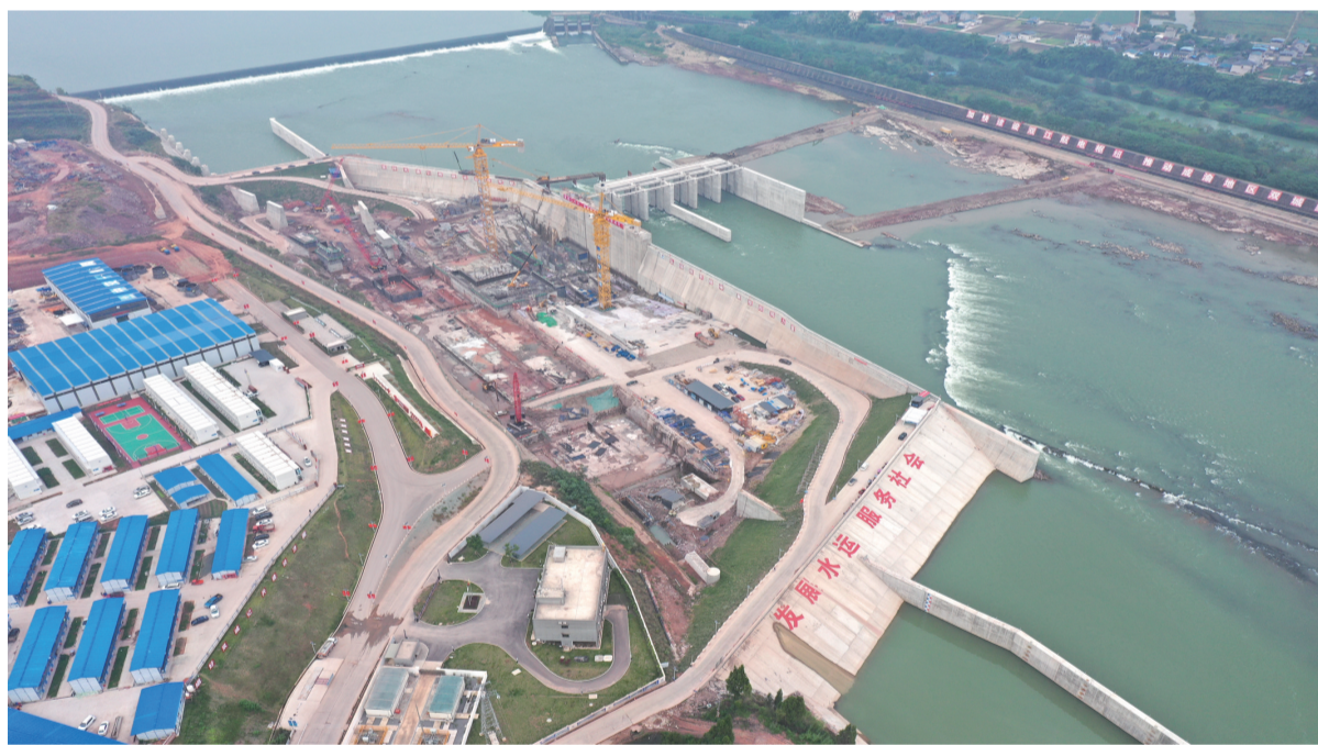
10月14日，高速集团旗下的潼南双江航电枢纽工程二期围堰成功合龙
