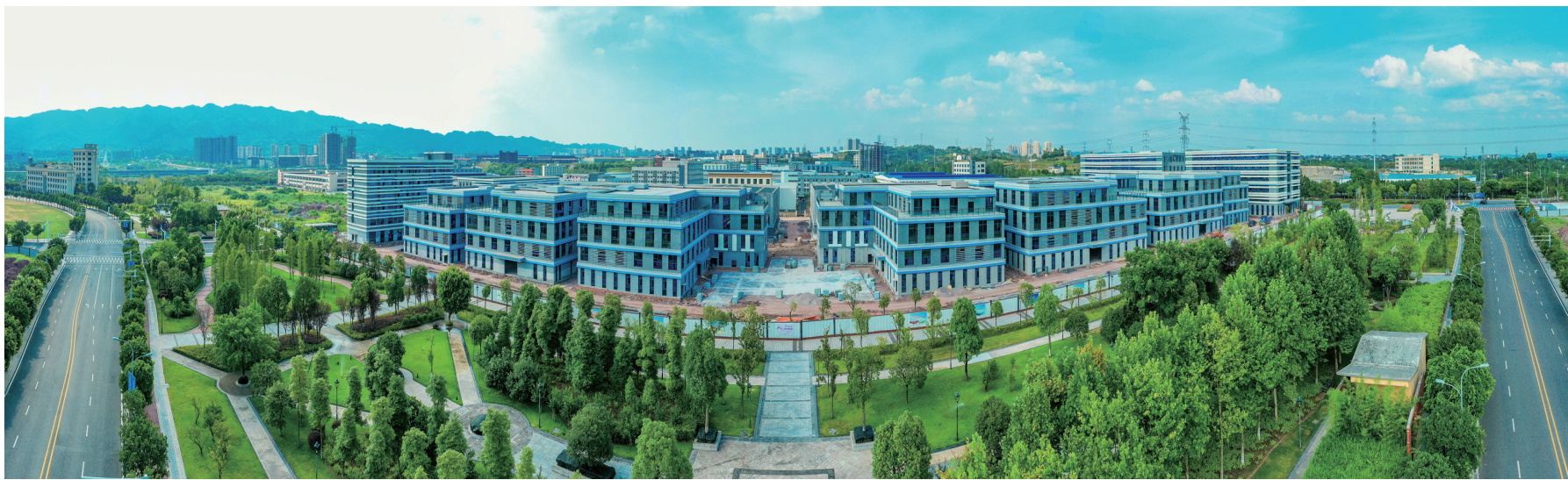
已建成的西部(重庆)科学城江津片区中(重)智慧产研城项目
