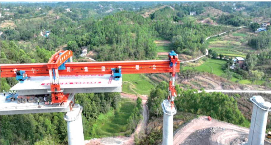
正在建设中的渝昆高铁永川段
