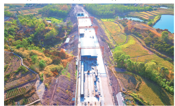
江泸北线高速（永川段）2#预制梁场建设完成
