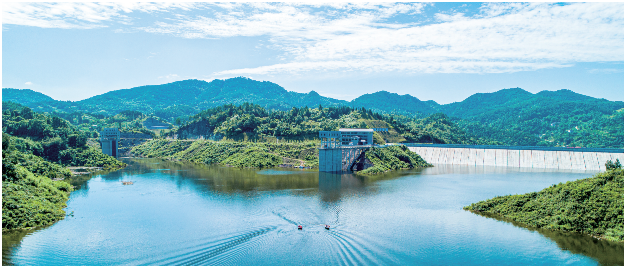
观景口水利枢纽工程于今年7月通过竣工验收，承担着380万人生活应急供水任务
