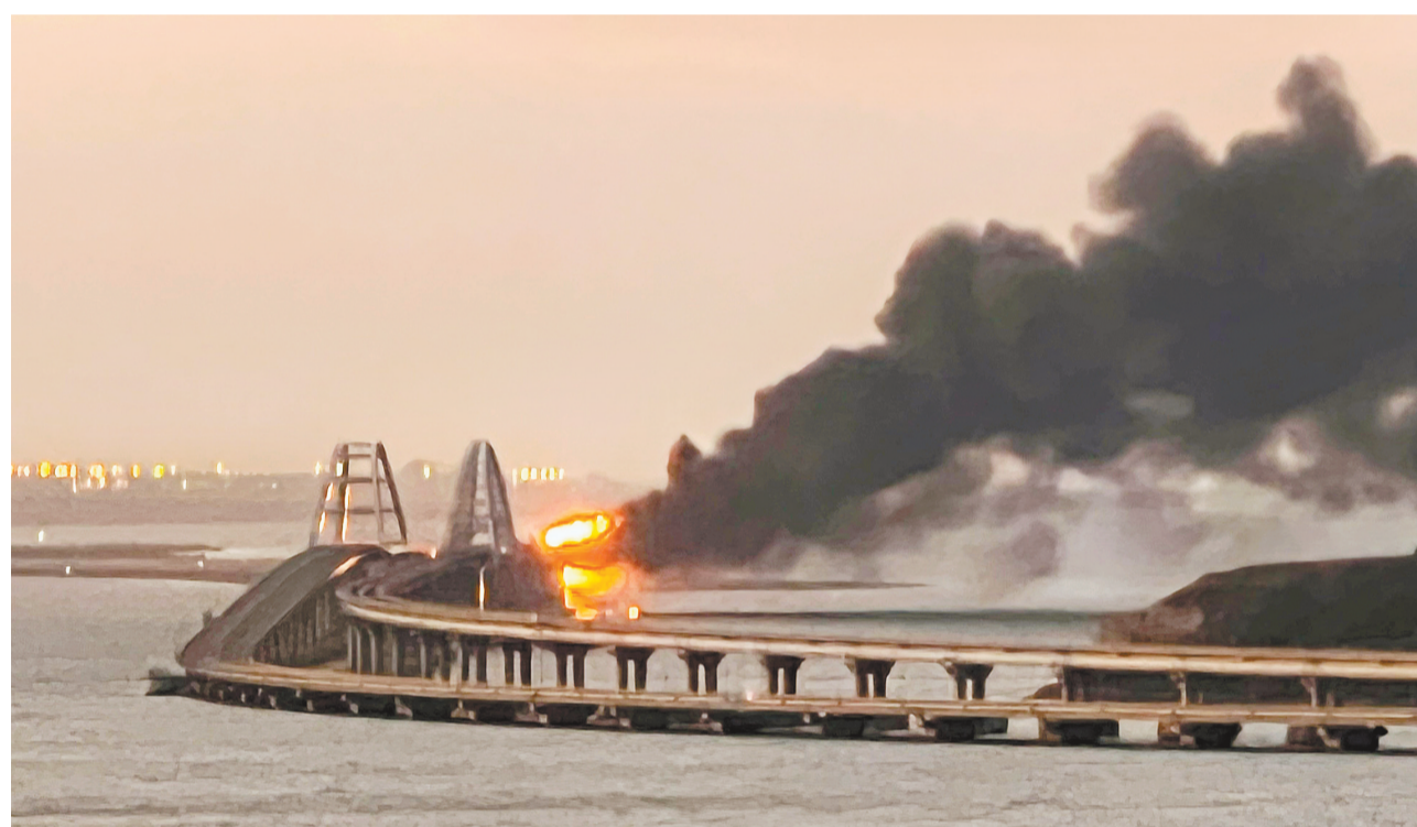
克里米亚大桥起火现场。
