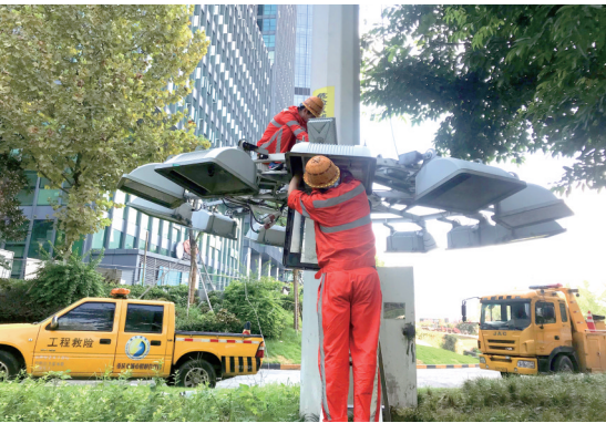
市照明中心工作人员维修高杆灯
