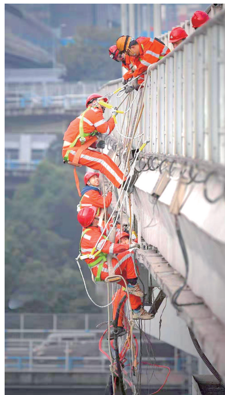
市照明中心工作人员维修大桥夜景灯饰
