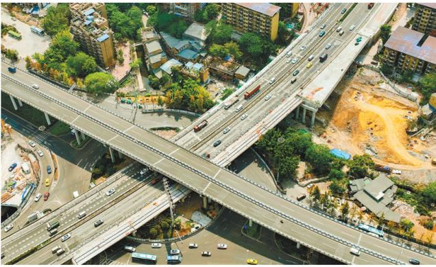
近日，内环快速路沙坪坝段拓宽改造工程有序推进。该工程为市级重点项目，全长5480米，起点接西环立交，终点接花园大桥南桥头，拟将现有双向6车道加应急停车带拓宽为双向10车道。目前已完成整个项目工程量的约80%，预计年内实现主线通车，届时该段通行能力将提升1/3以上。
