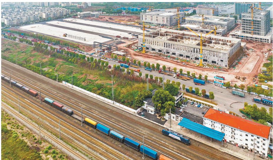
9月21日,位于沙坪坝区的重庆国际物流枢纽园区,陆海新通道重庆无水港项目正在加紧施工。该项目建筑面积约10.7万平方米,目前主体工程已基本完成,正在进行市政环境配套工程及内部安装工程。11月,堆场、仓库将达到使用要求。 记者 张锦辉 摄/视觉重庆
