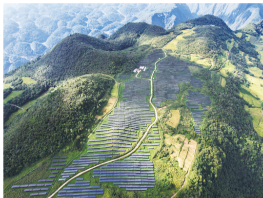
光伏发电项目
